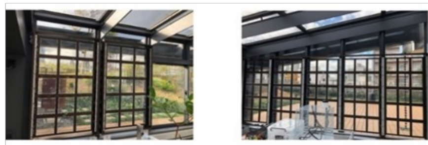
後付け工法による光発電ガラスの試作設置例
